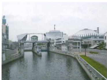
道頓堀川水門
